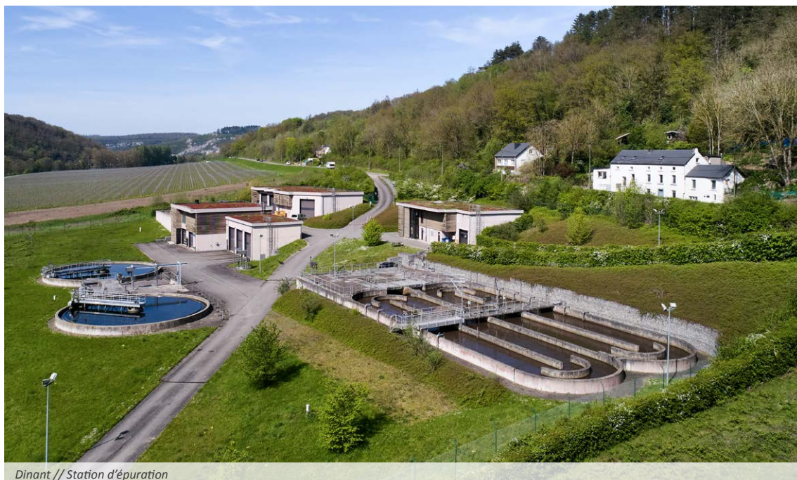
Dinant // Station d'épuration
