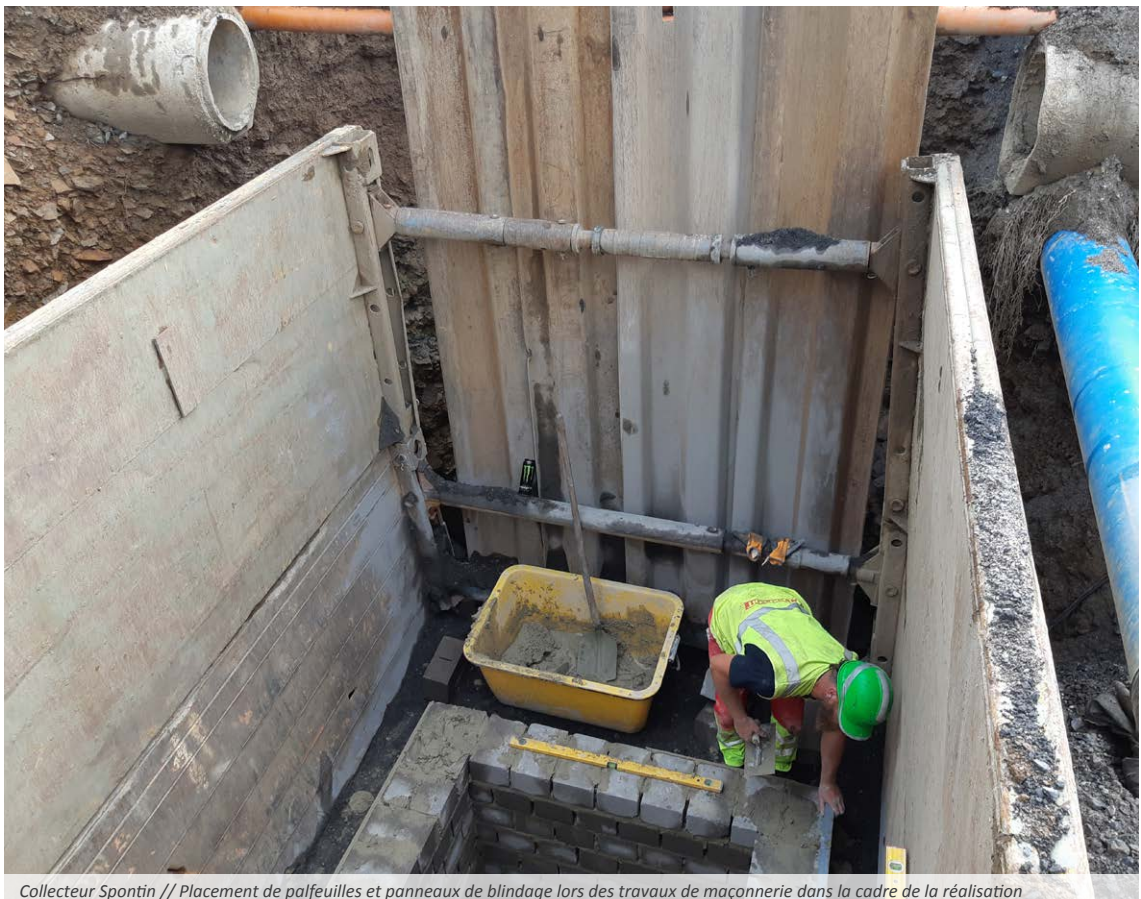
Collecteur Spontin // Placement de palfeuilles et panneaux de blindage lors des travaux de maçonnerie dans la cadre de la réalisation
