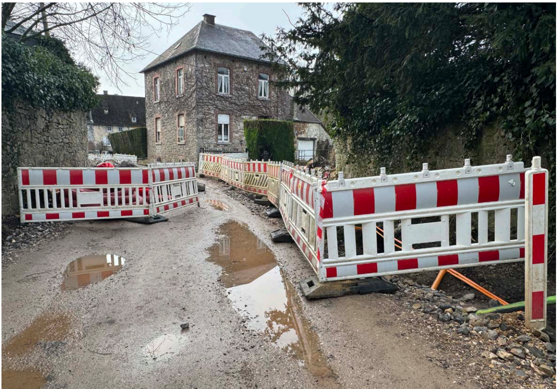
Annevoie // Placement de barrières de sécurité dans le cadre de travaux d'égouttage et de la réfection place
