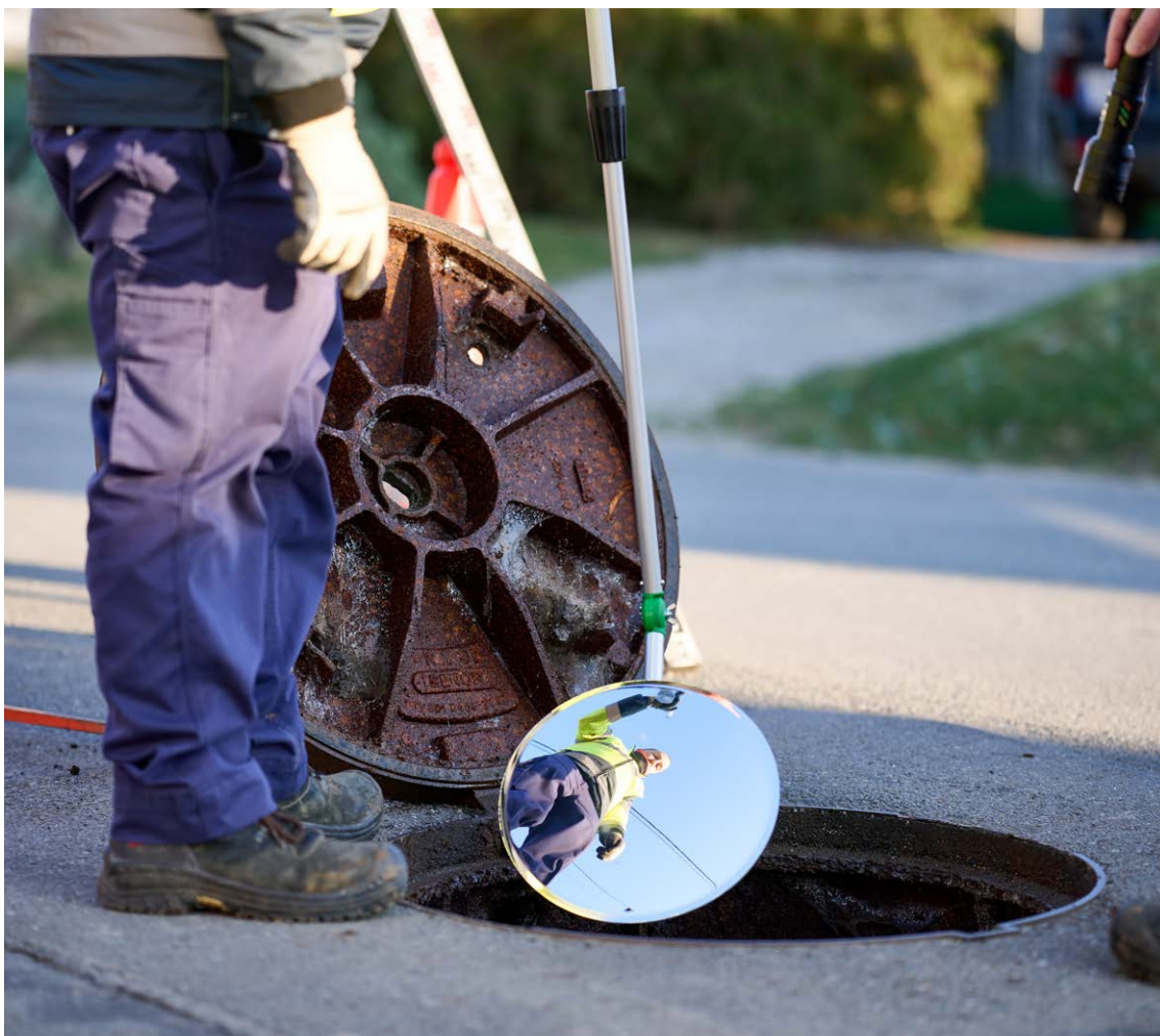
Ouverture d'une chambre de visite par un technicien de l'INASEP
