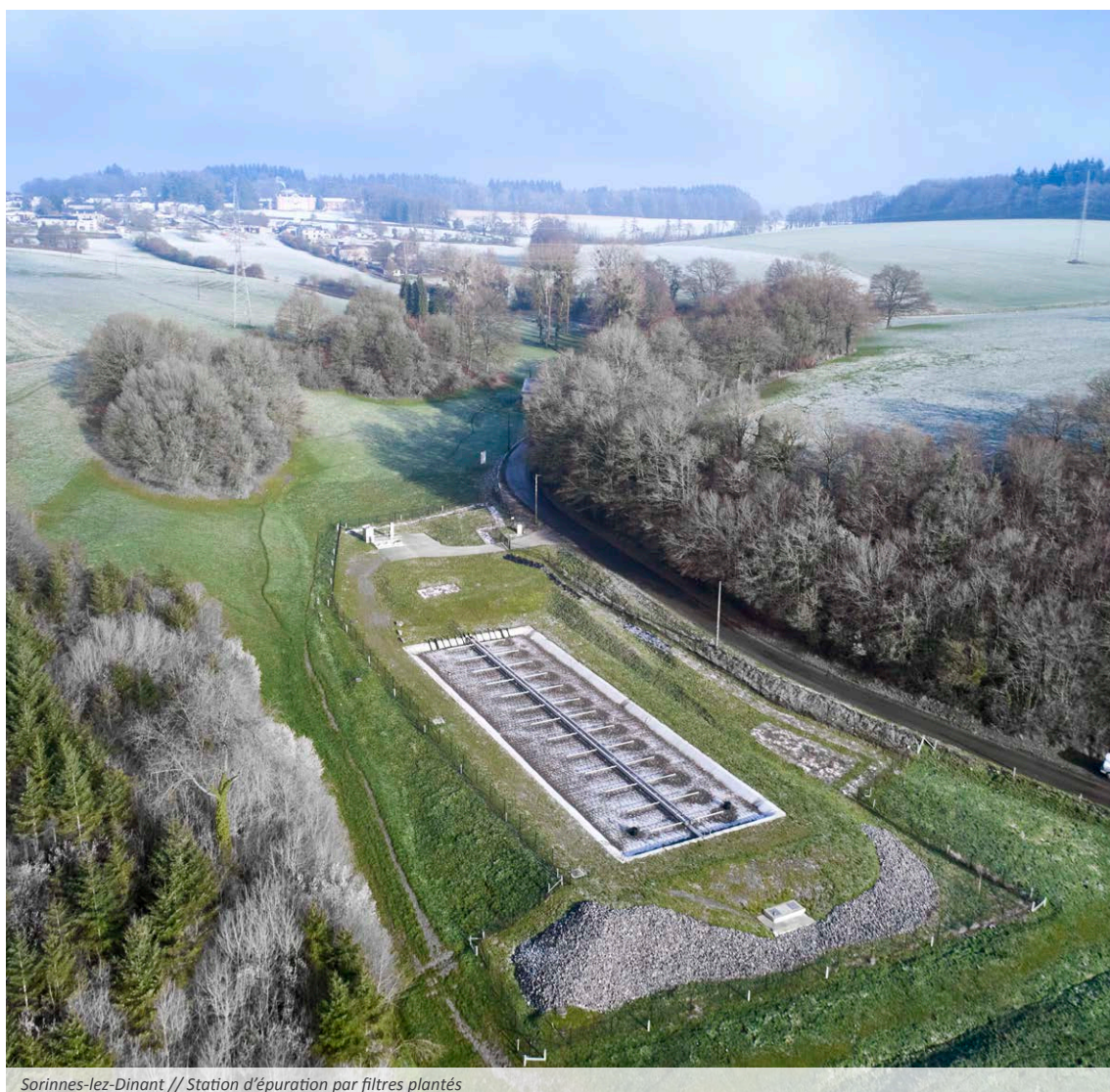
Sorinnes-lez-Dinant // Station d'épuration par filtres plantés
