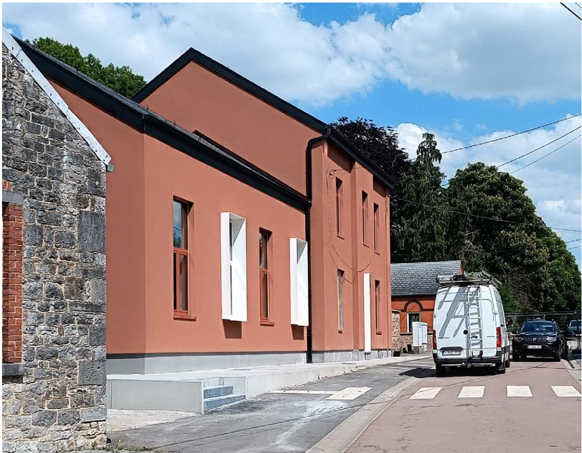
Florennes // Rénovation de l'école de Chaumont
