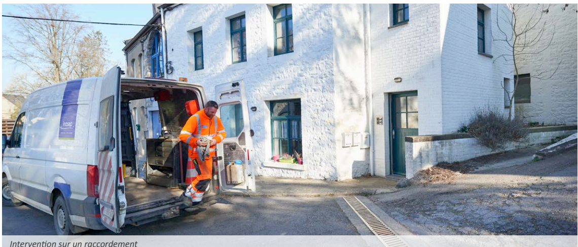
Intervention sur un raccordement
