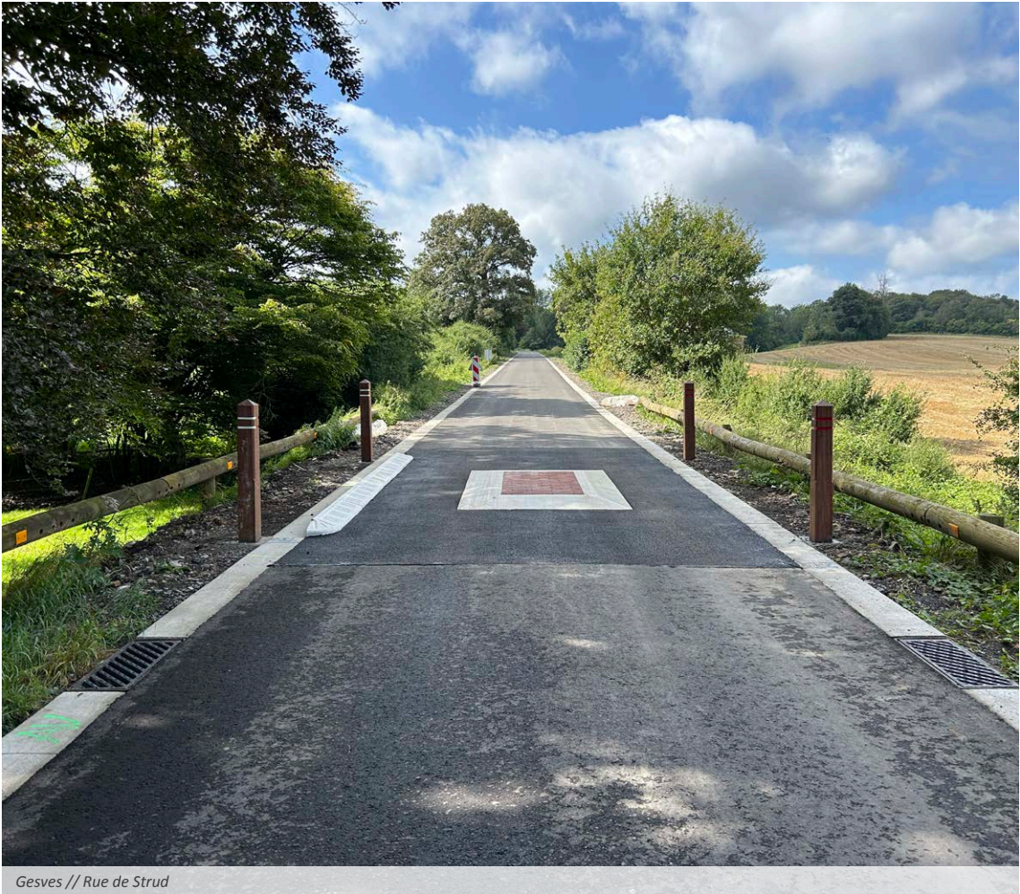
Gesves // Rue de Strud
